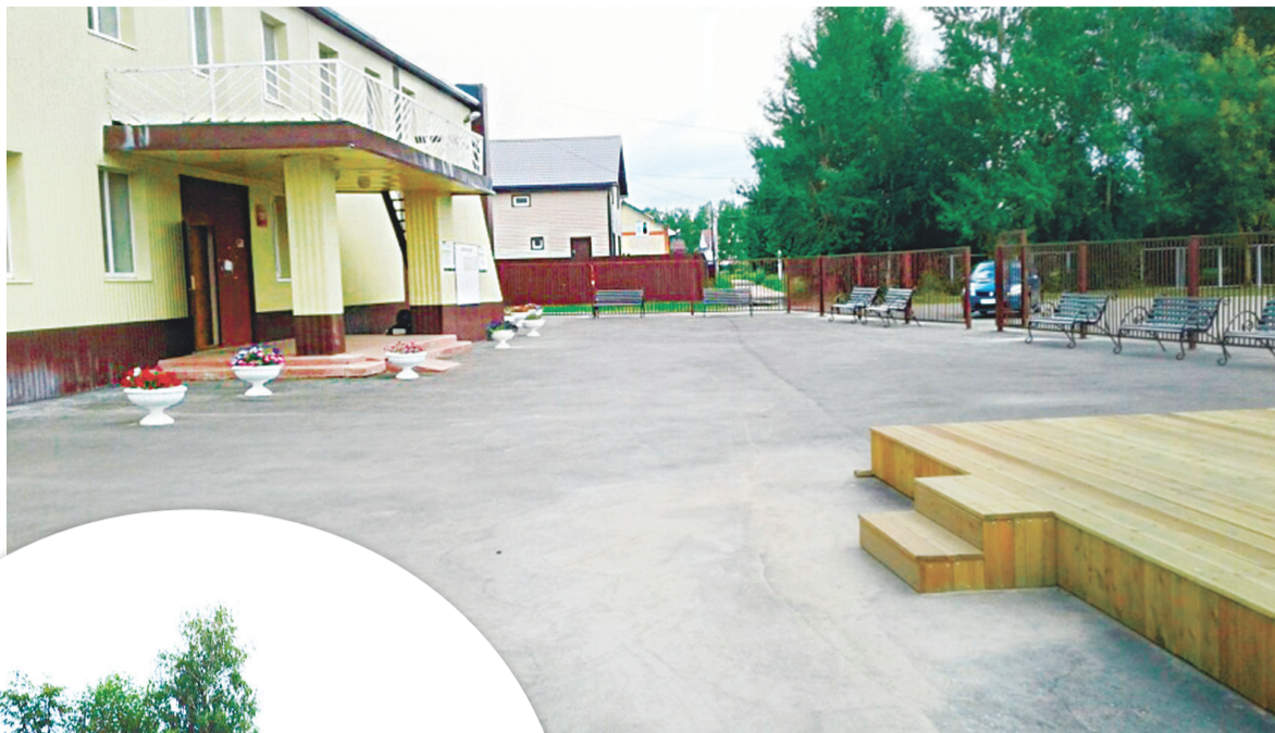
Ремонт площади у ДК села Сарафоновна
